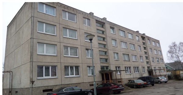
2 pav. Šiaurinis fasadas
