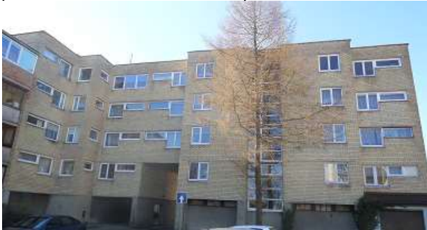
1 pav. Šiaurinis fasadas
