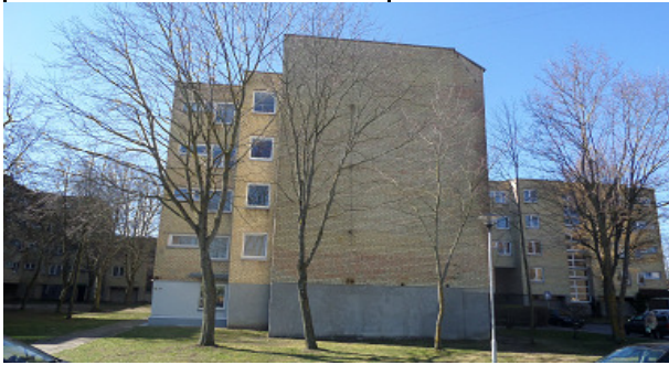
1 pav. Šiaurinis fasadas
