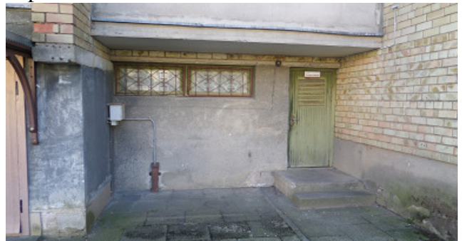
6 pav. Rūsio lauko durys, langas, cokolis
