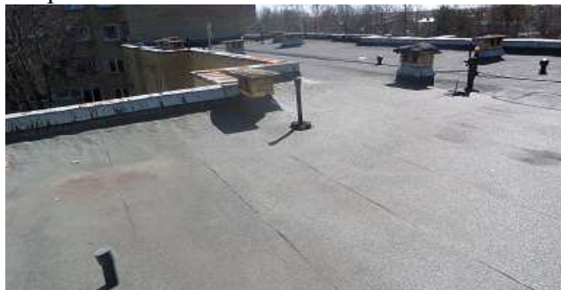
14 pav. Sutapdintas stogas
