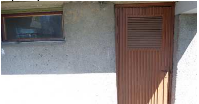
6 pav. Rūšio langas, lauko durys, cokolis
