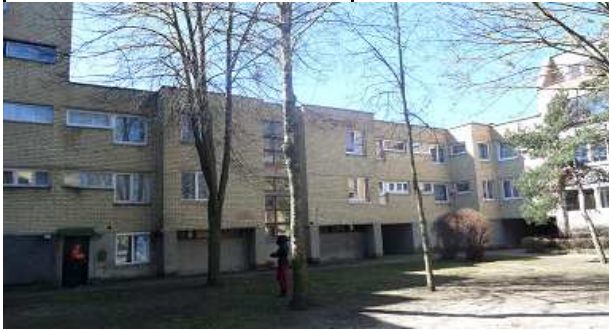
1 pav. Šiaurinis fasadas
