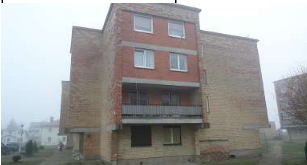
1 pav. Šiaurinis fasadas
