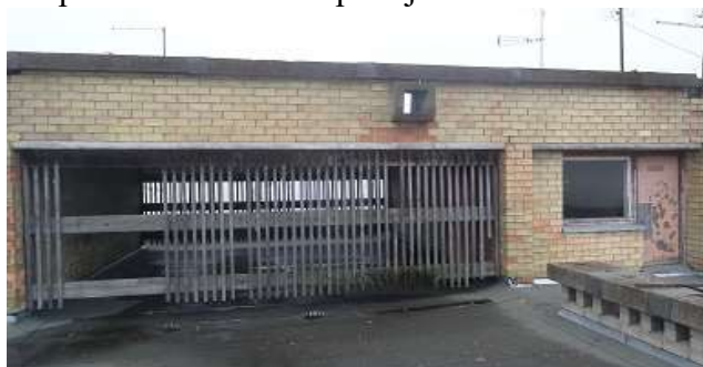
12 pav. Užlipimo ant stogo durys, džiovykla
