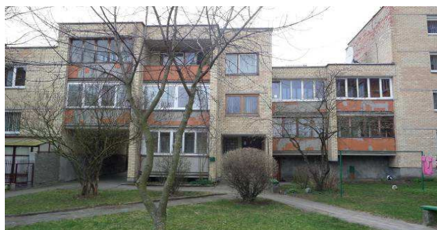
3 pav. Rytinis fasadas
