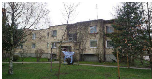
5 pav. Šiaurinis fasadas
