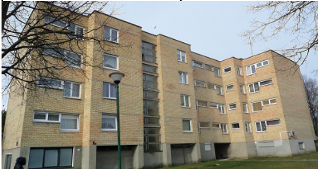
1 pav. Šiaurinis fasadas
