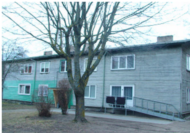
3 pav. Rytų fasadas
