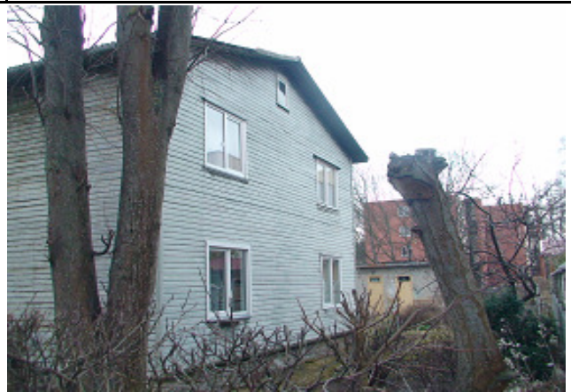
2 pav. Šiaurės fasadas
