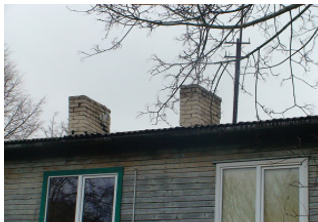
20 pav. Ventiliacijos kaminėliai
