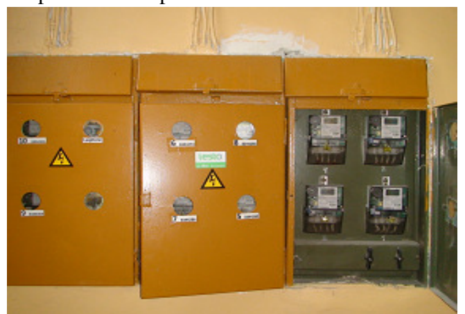
16 pav. Butų el. apskaitos spinta
