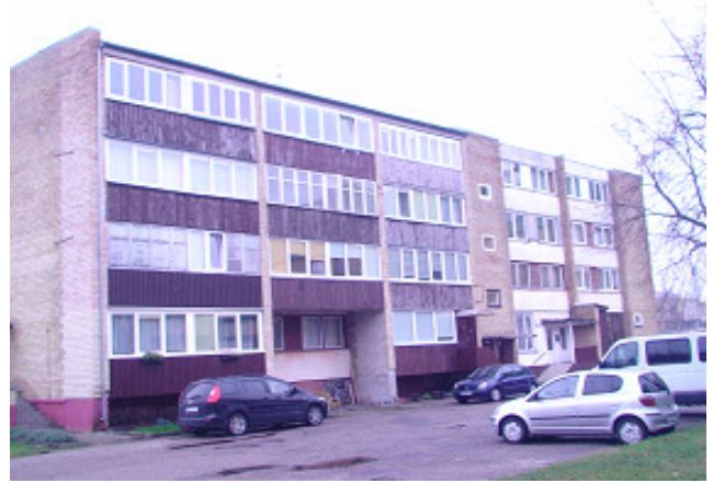
4 pav. Šiaurės vakarų fasadas
