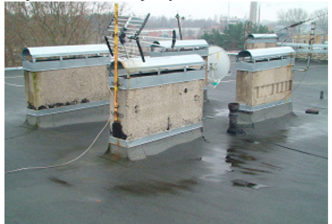
20 pav. Ventiliacijos kanalai
