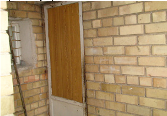
5 pav. Laiptinės balkono durys
