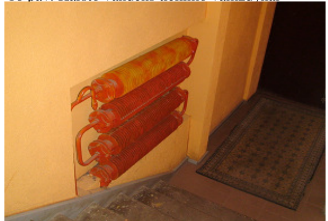
18 pav. Radiatorius laiptinėje
