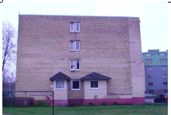
2 pav. Šiaurės rytų fasadas
