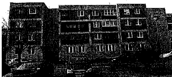
1 pav. Rytinis - šiaurinis fasadas
