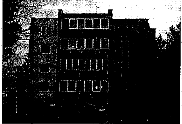
4 pav. Šiaurės vakarų fasadas
