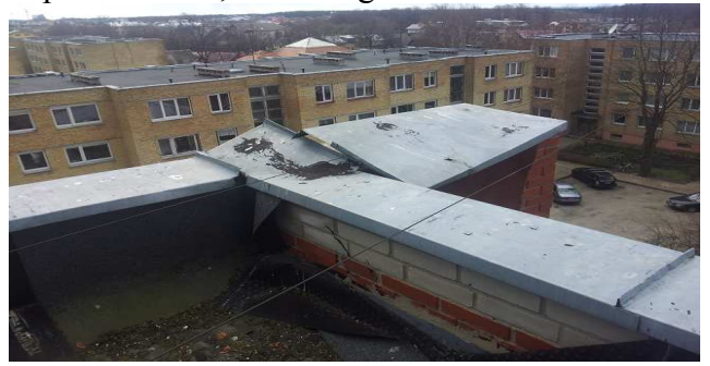
10 pav. Nepritvirtintas parapeto apskardinimas
