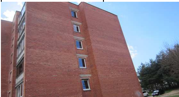
1 pav. Šiaurinis fasadas
