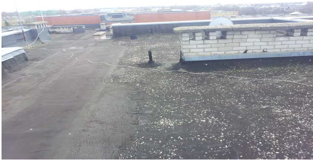
9 pav. Sutapdintas stogas
