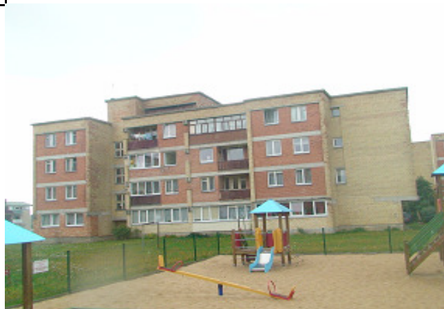
2 pav. Šiaurės vakarų fasadas
