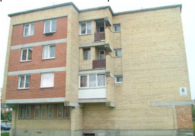
1 pav. Šiaurės rytų fasadas
