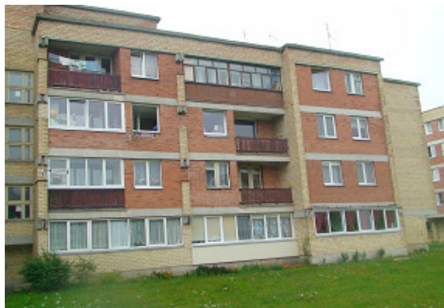
8 pav. Butų balkonai
