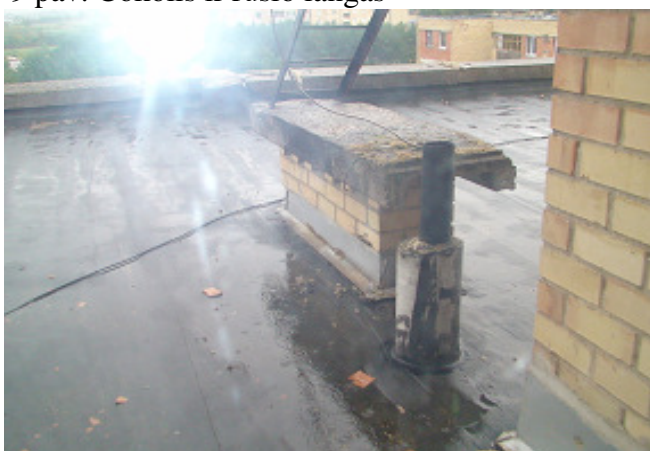
11 pav. Ventiliacijos kaminėlis
