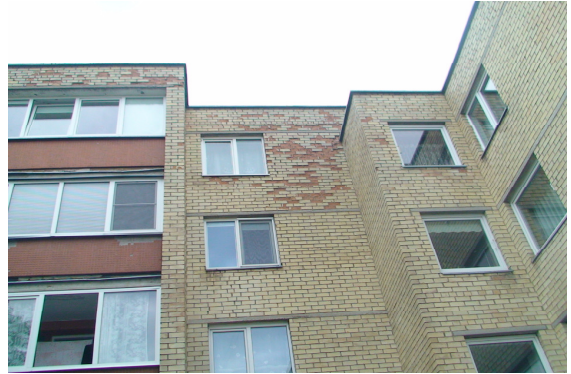
14 pav. Butų langai, atrupėjusi siena
