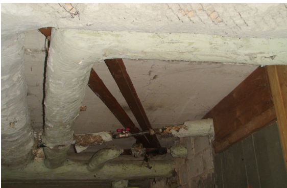
19 pav. Karšto vandens vamzdynai
