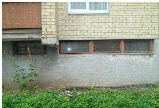
8 pav. Rūsio langai, cokolis
