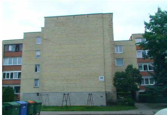
3 pav. Šiaurės vakarų fasadas
