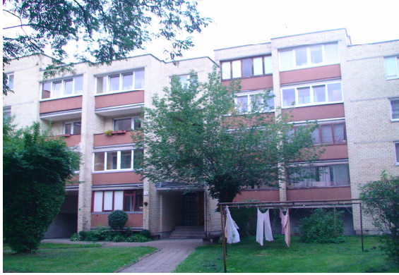
1 pav. Pietrytinis fasadas
