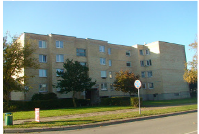
4 pav. Šiaurės fasadas
