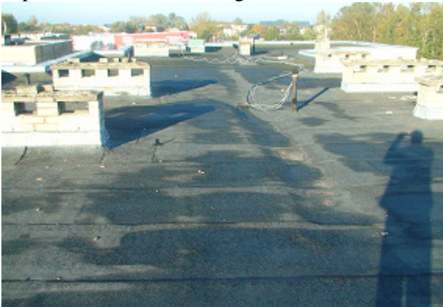
11 pav. Ventilacijos kaminėlis
