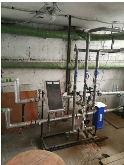
11 pav. Pastato šilumos punktas
