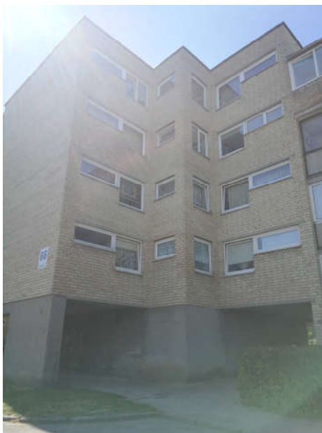
5 pav. Šiaurinis fasadas
