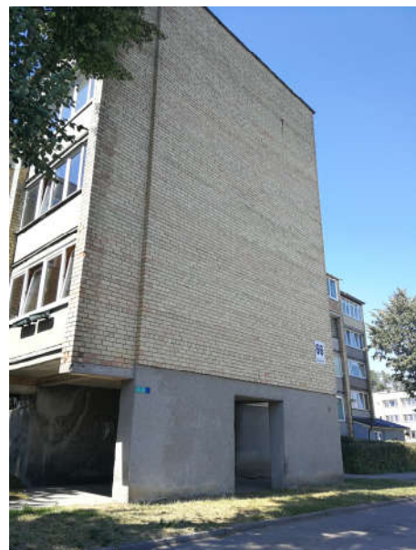
4 pav. Rytinis fasadas
