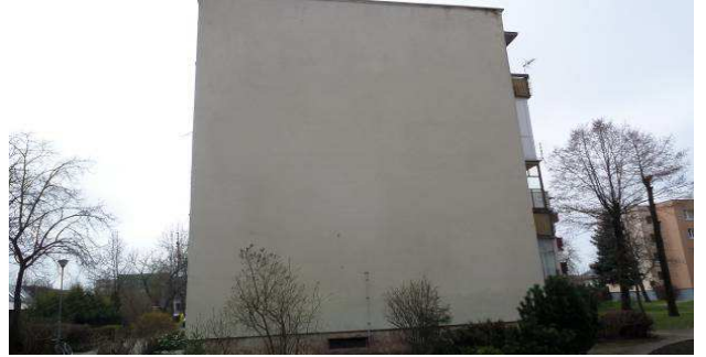
2 pav. Šiaurinis fasadas
