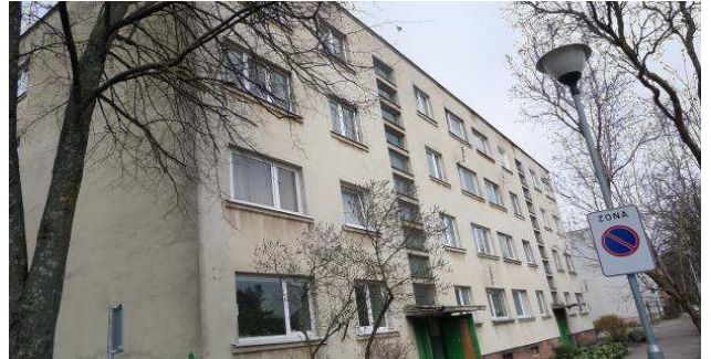
4 pav. Rytinis fasadas
