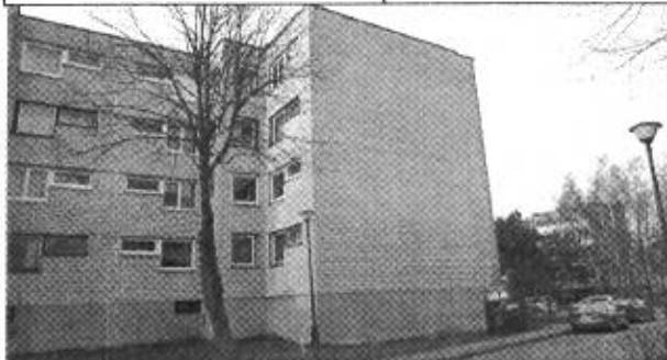
1 pav. Šiaurinis fasadas
