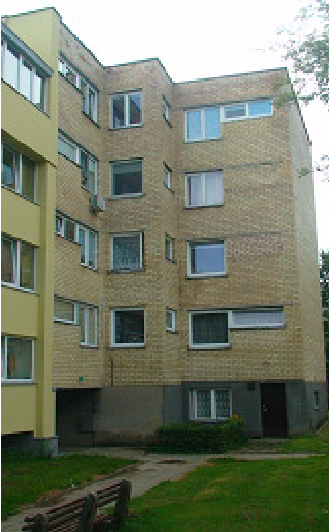
1 pav. Šiaurės rytų fasadas
