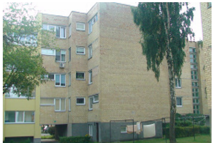
2 pav. Šiaurės vakarų fasadas
