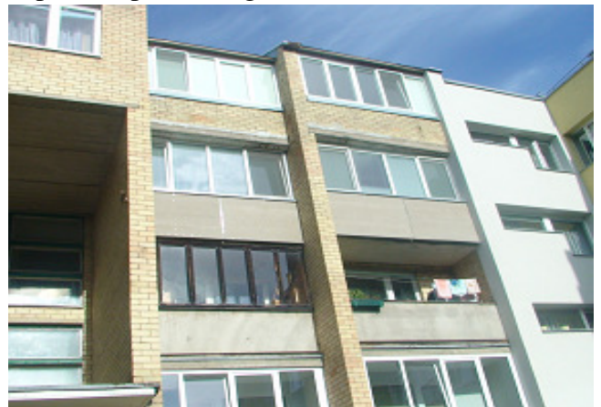
8 pav. Butų balkonai
