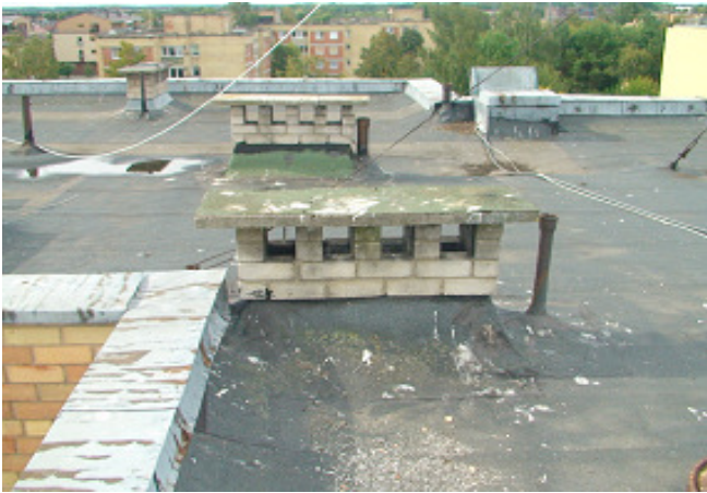
11 pav. Ventiliacijos kaminėlis
