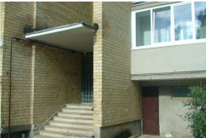
9 pav. Cokolis ir rūšio langas ir lauko durys
