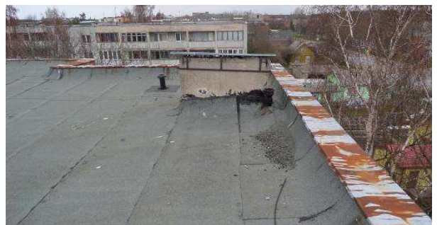
13 pav. Stogas, ventiliacinės angos
