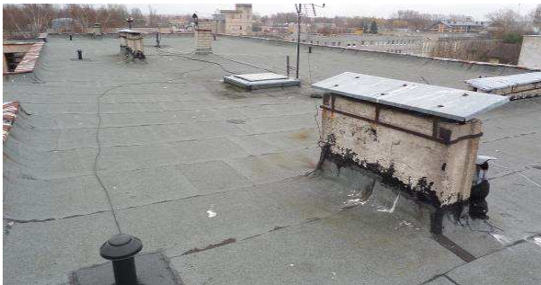
12 pav. Stogas, ventiliacinės angos
