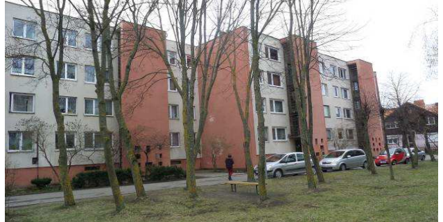
2 pav. Šiaurinis fasadas
