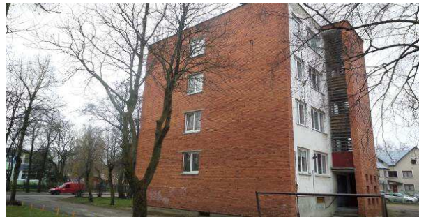
4 pav. Rytinis fasadas
