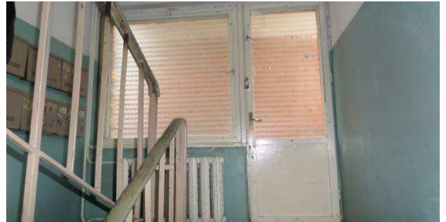
9 pav. Laiptinės balkono durys ir langas. Radiatorius laiptinėje.
