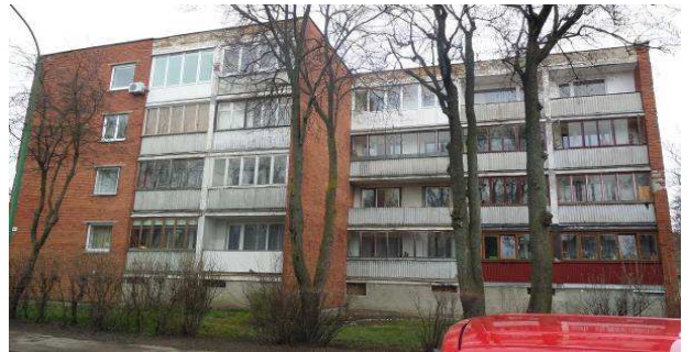
2 pav. Šiaurinis fasadas
