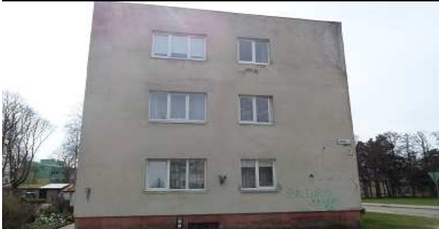
1 pav. Šiaurinis fasadas
