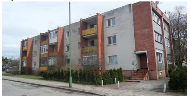
6 pav. Buto Nr. 2 lauko durys, pristatyti balkonai
