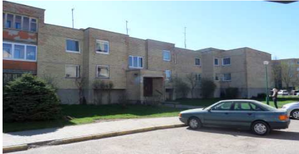
1 pav. Šiaurės vakarų fasadas
