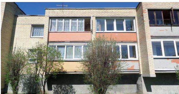
5 pav. Balkonai, apirusios plytų sienos
