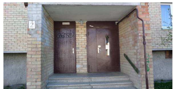
8 pav. Rūšio ir laiptinės lauko durys, cokolis
