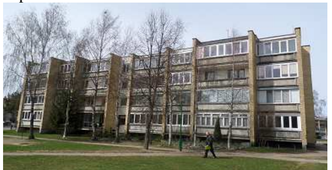
4 pav. Rytinis fasadas
