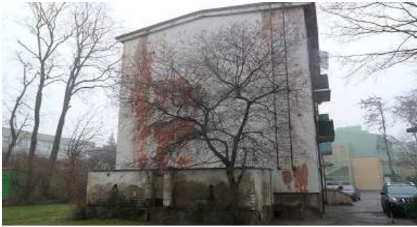
1 pav. Šiaurinis fasadas
