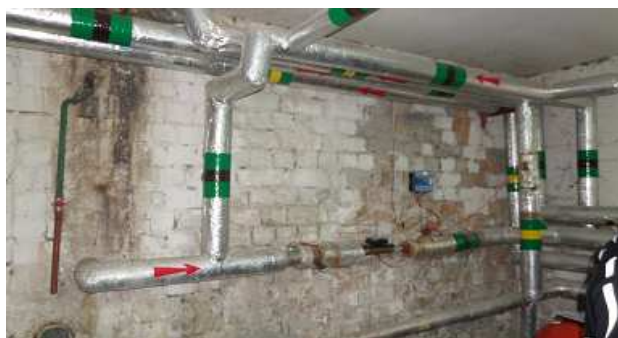
10 pav. Apskaita ant įvado
