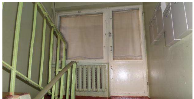
8 pav. Laiptinės balkono durys ir langas. Radiatorius laiptinėje.
