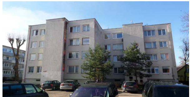
2 pav. Šiaurinis fasadas
