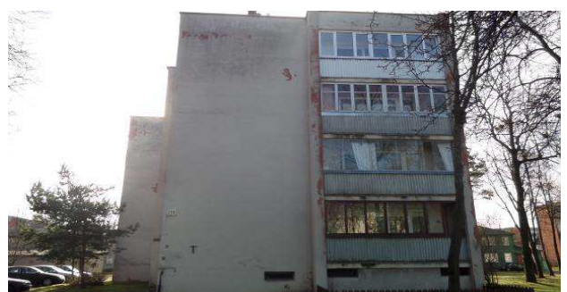
4 pav. Rytinis fasadas
