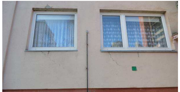
10 pav. Buto langai, temperatūros daviklis automatiniam šildymo sistemos valdymui
