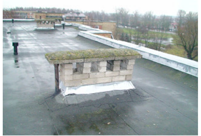
20 pav. Ventiliacijos kanalai
