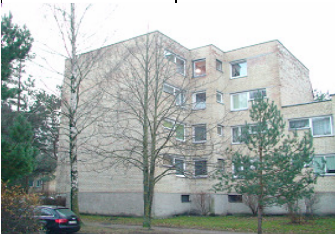
1 pav. Šiaurės fasadas
