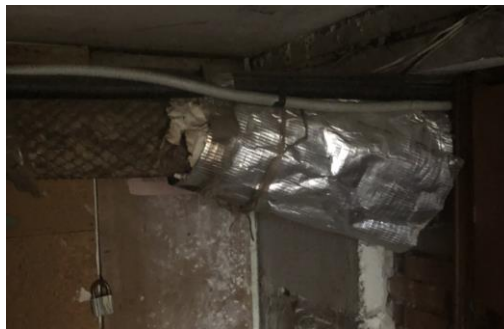
10 pav. Vamzdynų apšiltinimas
